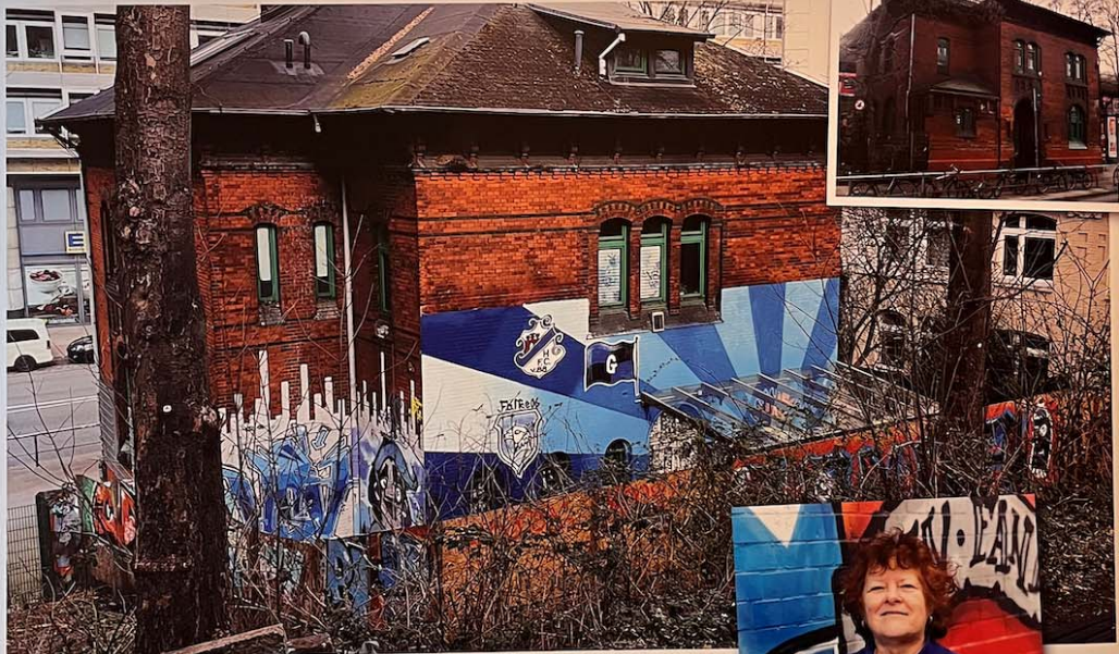
Die Räume des HSV Fanprojekts befinden sich seit 1988 im HSV-Fanhaus, zentral gelegen an der S-Bahn Haltestelle Holtenstraße. Das Fanhaus ist denkmalgeschützt und war in der Vergangenheit unter anderem eine Polizei-Dienststelle. Seine Nutzung während der Zeit des Nationalsozialismus ist bisher noch nicht aufgearbeitet worden.
